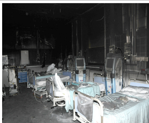
Un'immagine della Dialisi dopo l'incendio del 30 giugno 2012
